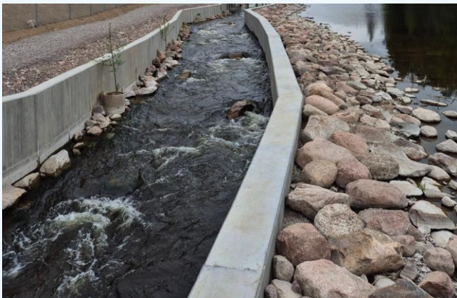
Träd planterade utmed vänstra väggen.
